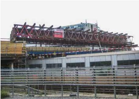
Fachwerkgerüst mit abgehängter Schalung
